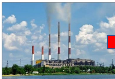
Електрична станція 330 000 В
